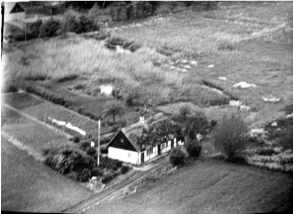
Gundslevmaglevej 7, ca. 1949. Set fra sydøst.
